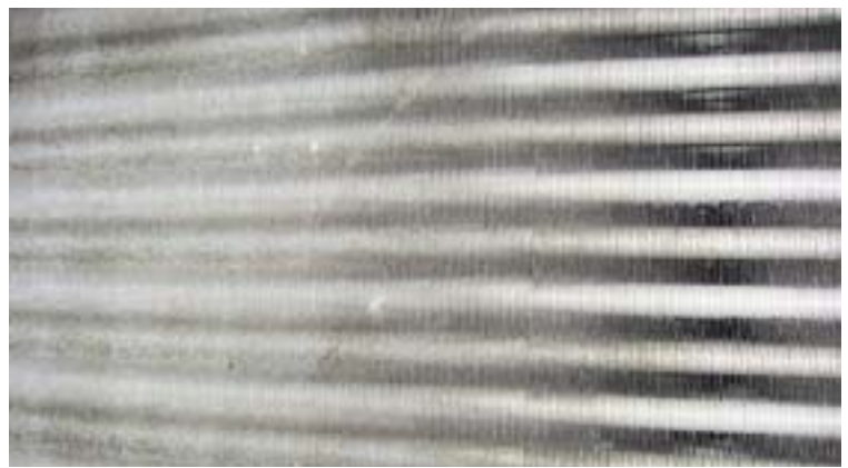
Figura 2 – Batteria di scambio termico, prima e dopo la pulizia
