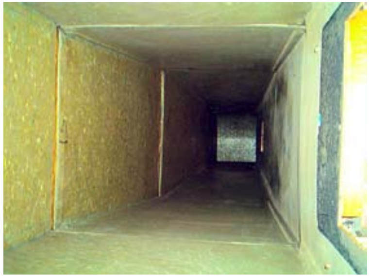
Figura1 – Condotto aeraulico, prima e dopo la pulizia
